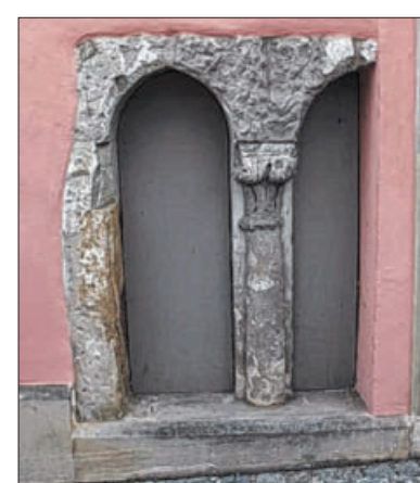
Das kleine doppelte Rundbogenfenster am Kaufhaus Woha. Archivfoto: smu
